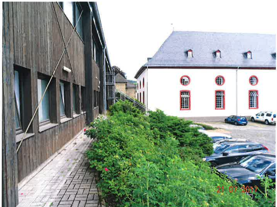
42. Höhengsituation an der Reithalle – Blick Richtung Norden
