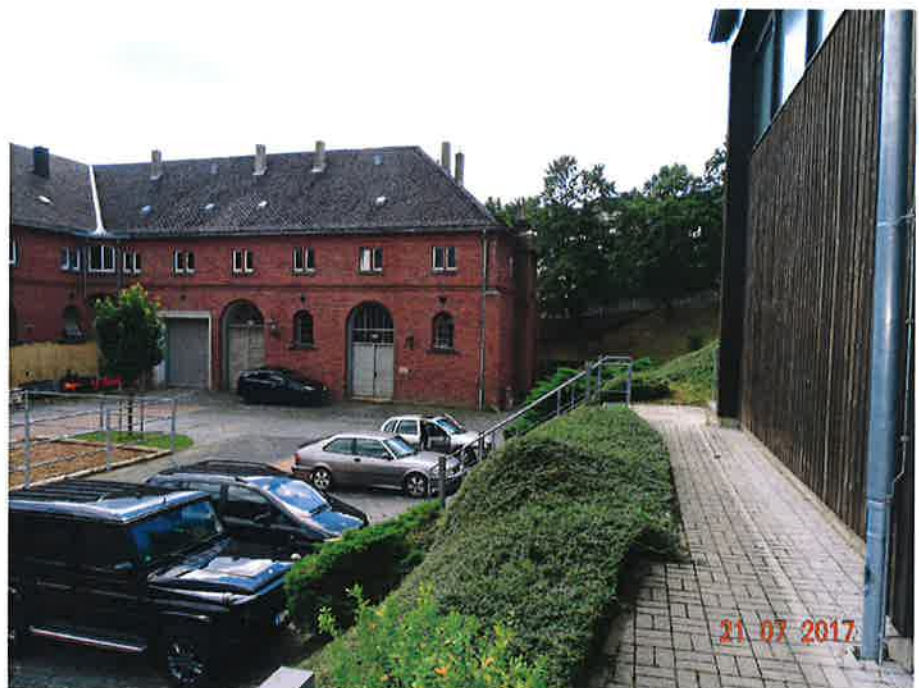
43. Höhengsituation an der Reithalle – Blick Richtung Süden
