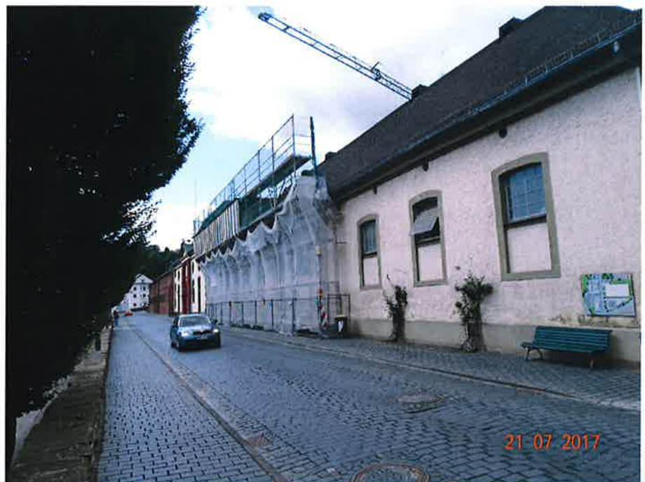
38. Wilhelmstrasse - Blick in Richtung Süden
