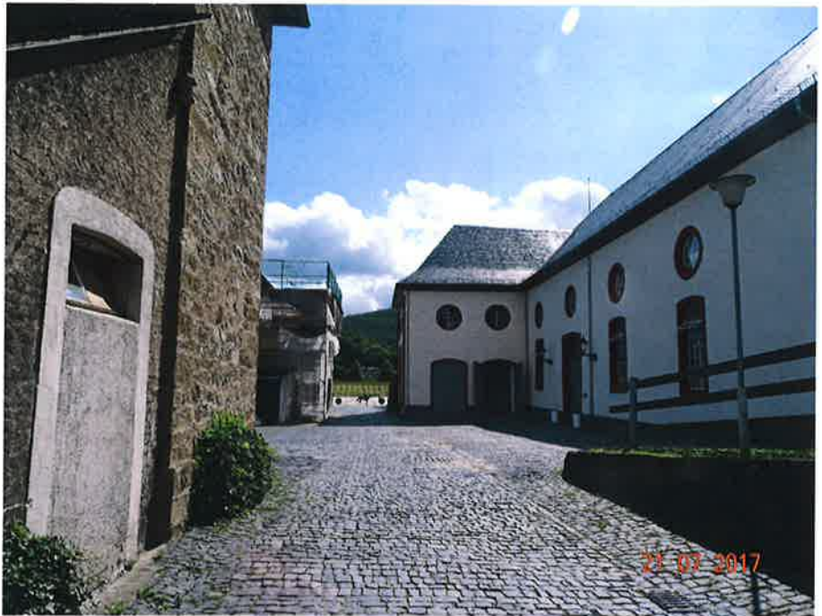
09. Zentraler Blick in Richtung Paradeplatz
