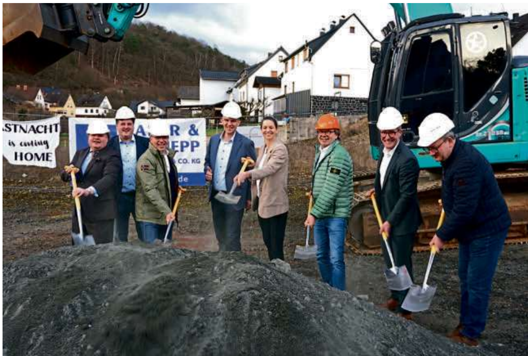
Der erste Spatenstich erfolgte durch Klaus-Achim Wendel, Friedrich Dehmer, Michael Lotz, Frank Inderthal, Ann-Katrin Lieblang, Hansi Fuchs, Carsten Braun und Thilo Schwarz von Dessonneck (v.l.). Foto: Helmut Blecher
