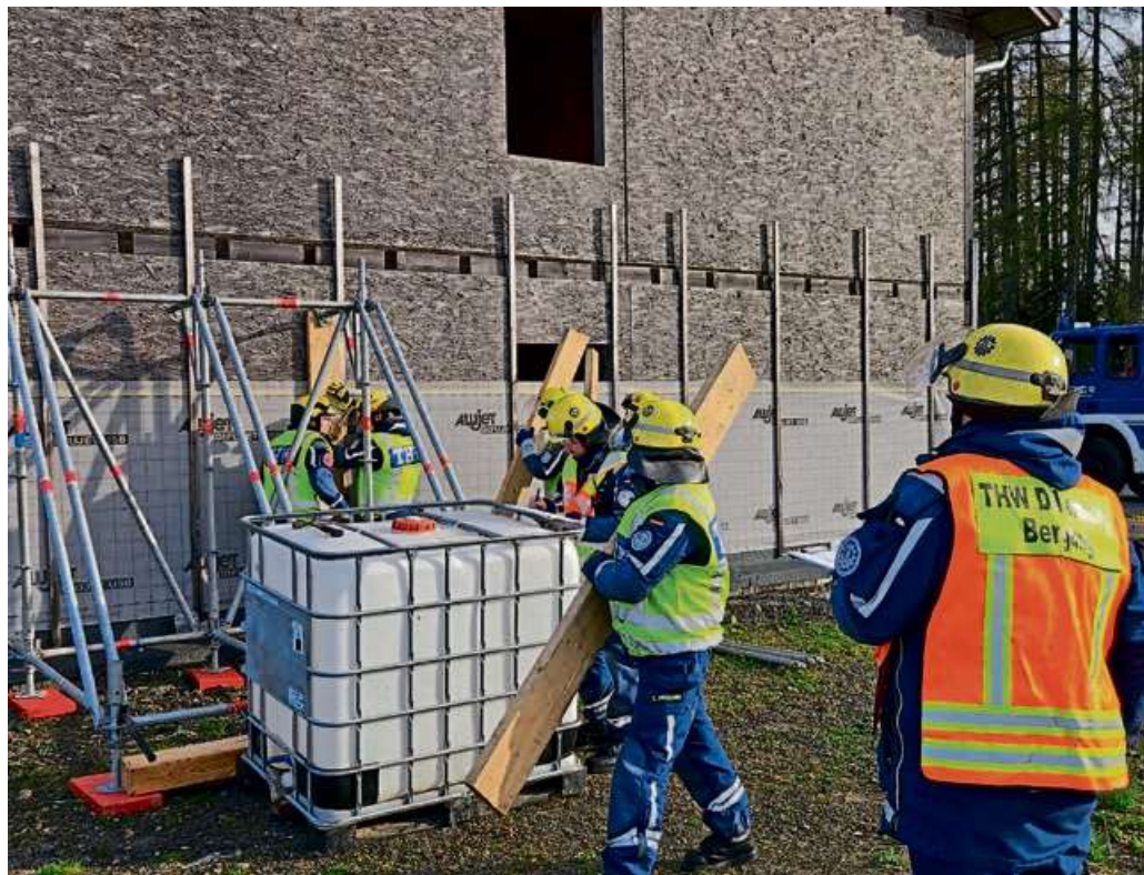
Auf dem Gelände in Frohnhausen waren sechs Übungsstationen aufgebaut. Hier muss die Gruppe eine Wandabstützung mit einem Einsatz-Gerüst-System montieren.
