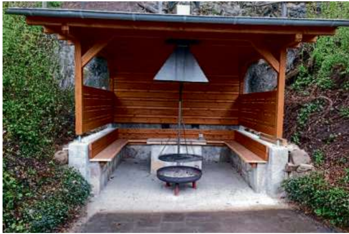
Die neue Grillhütte im Wildpark Donsbach bietet alles für eine schöne Familienfeier. Foto: Matthias Wagner
